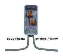
Die ausführende Firma des Modbus-Systems wird dann von dieser Abzweigdose die eBUS-Verbindung zur Unterverteilung mit dem ise smart connect Modbus Vaillant weiterführen (Diese Abzweigdose dient auch zum Trennen der eBUS-Verbindung im Service-Fall).
